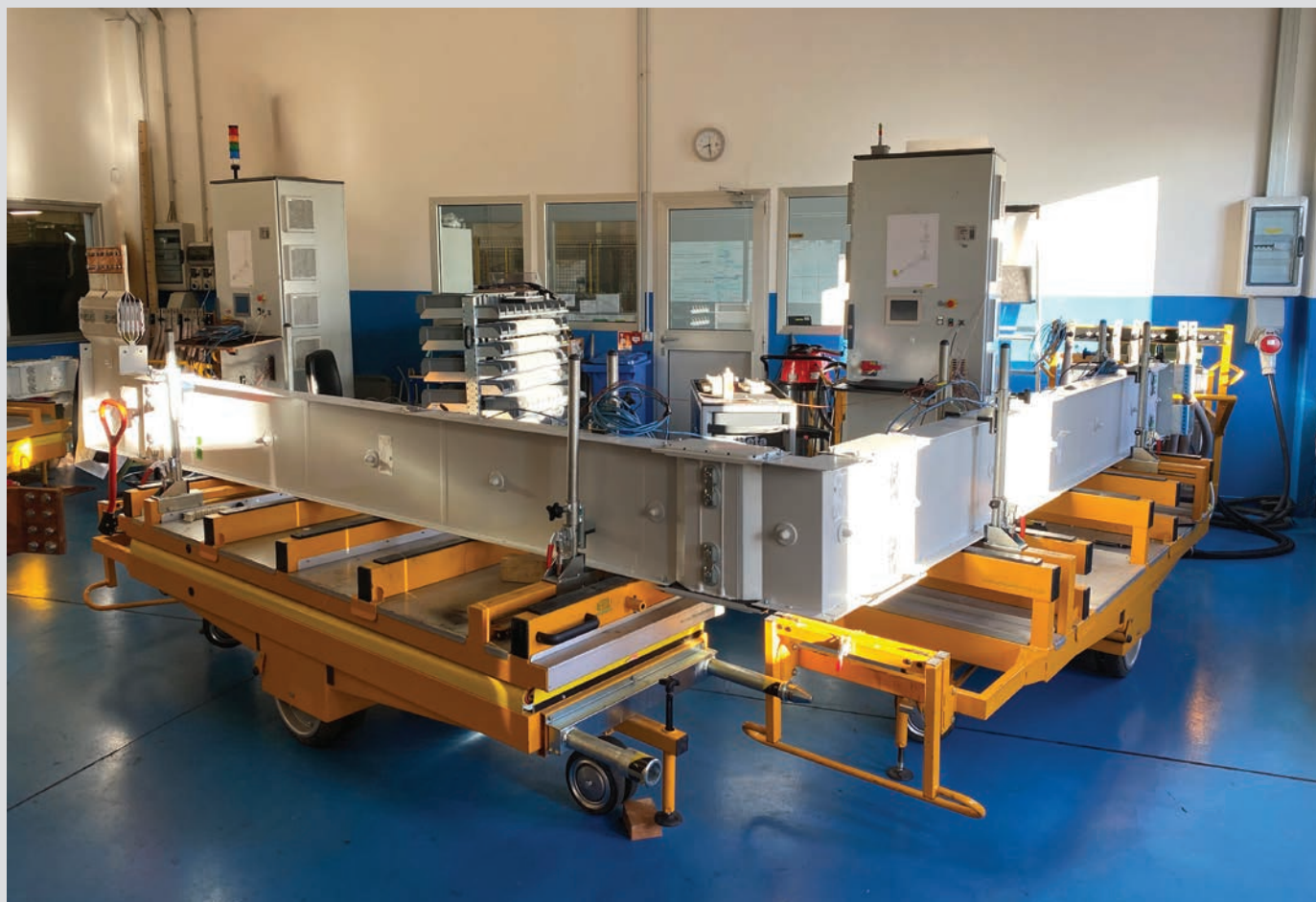
Il laboratorio BTicino durante i test per la certificazione dei condotti sbarre
