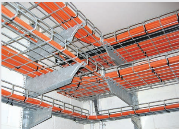
Esempio di installazione con passerella a filo
