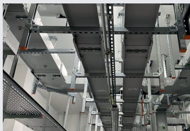
Esempio di installazione con condotti sbarre
