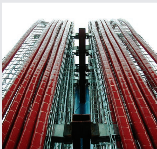
Esempio di dimensioni di installazione per un impianto di distribuzione in cavo
